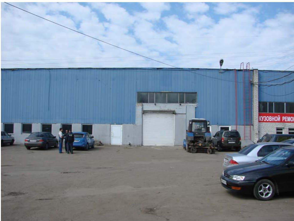
Здесь будет вход на приёмку и в цех
